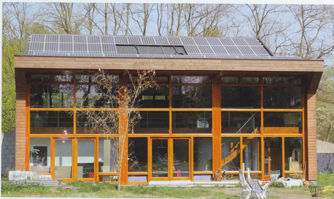
De te openen ramen bevinden zich zowel onder- als bovenin de gevel.
