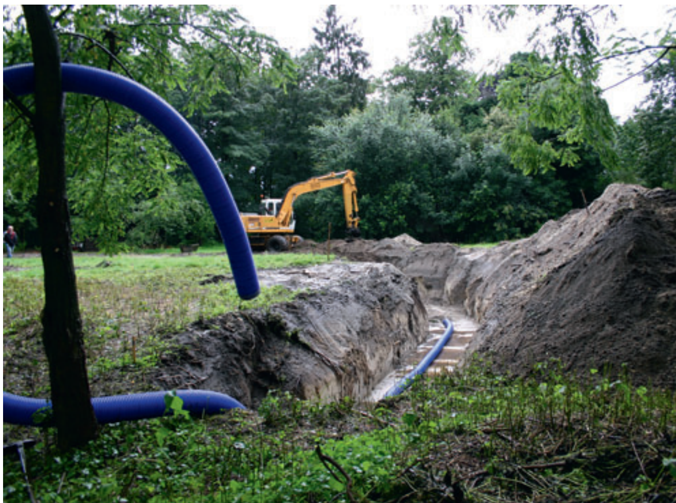
Ingraven van de 50 m lange grondbuis voor de nulwoning in Groenlo.
