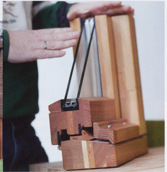
De kozijnen zijn geïsoleerd met puriet- en PUR-isolatie geïntegreerd in het hout. Het glas is driedubbel, alleen de middelste laag is geen glas maar folie
