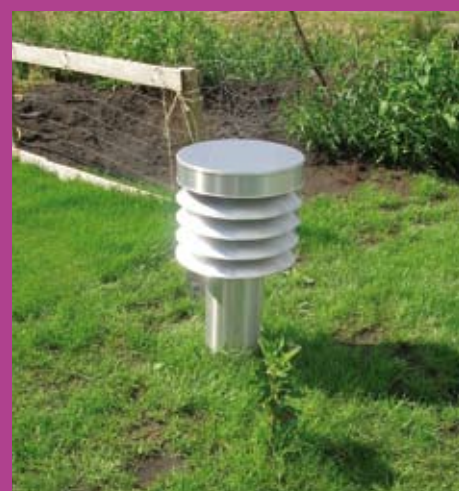
Luchtfilter voor een grondbuissysteem.
